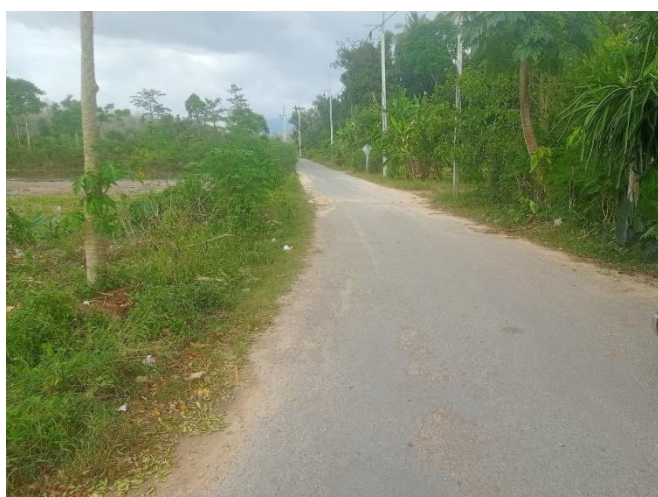
ภาพที่ ๓.ภาพก่อนดำเนินการ
