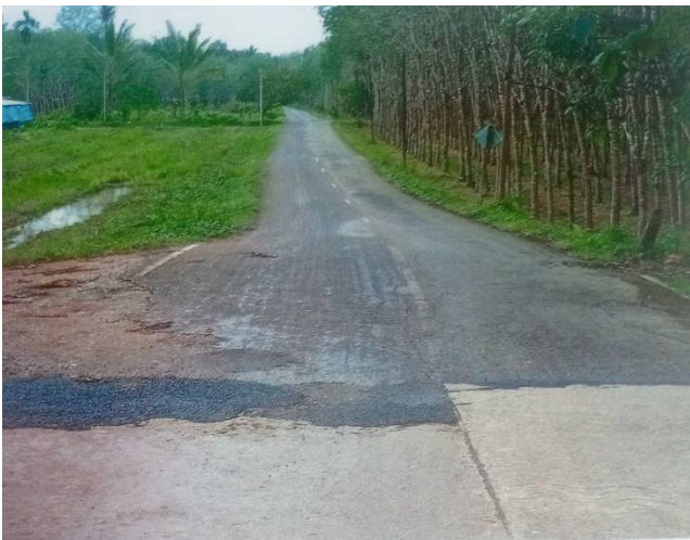
ภาพที่ ๑.ภาพก่อนดำเนินการ
