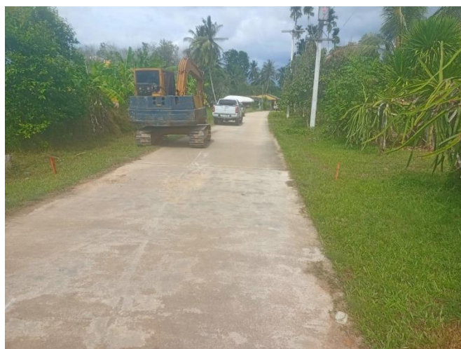
ภาพที่ ๒.ภาพก่อนดำเนินการ
