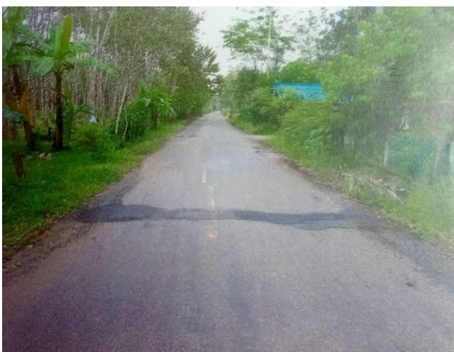
ภาพที่ ๓.ภาพก่อนดำเนินการ
