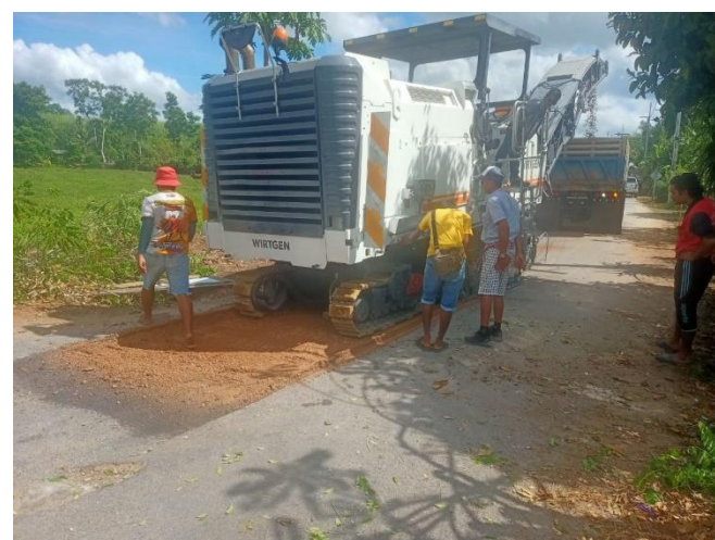
ภาพที่ ๔.ภาพก่อนดำเนินการ
