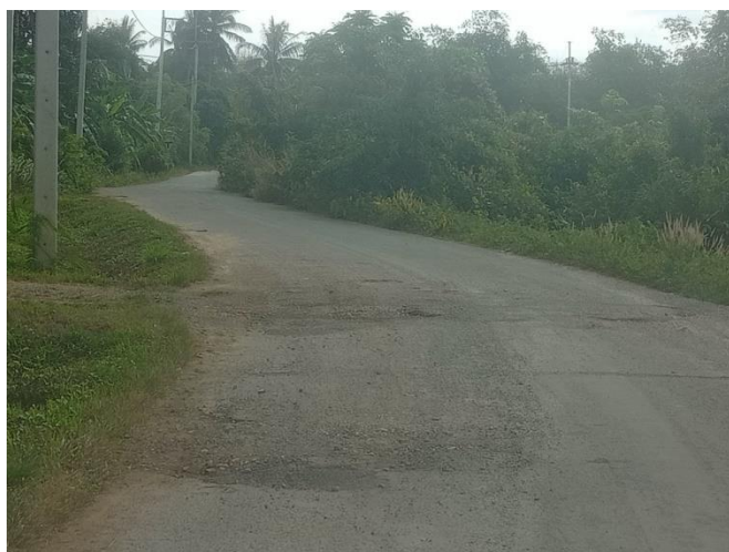
ภาพที่ ๑.ภาพก่อนดำเนินการ
