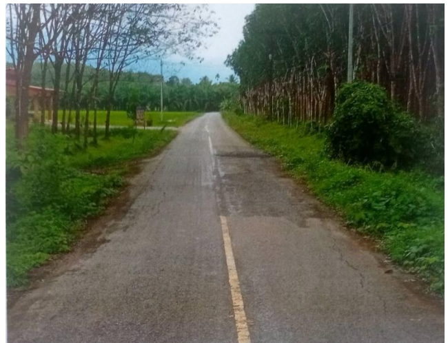
ภาพที่ ๒.ภาพก่อนดำเนินการ
